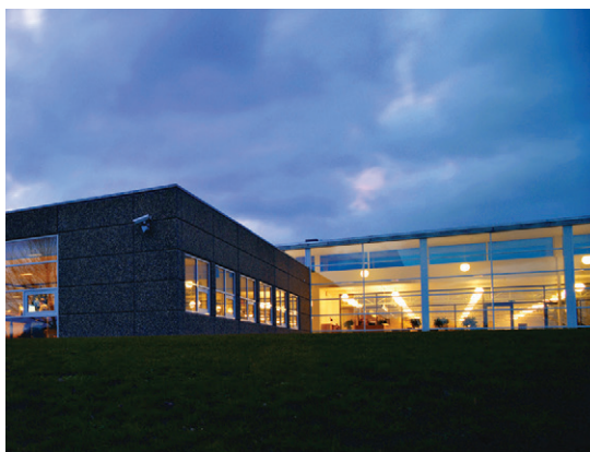
Завод в г. Вайле, Дания.
